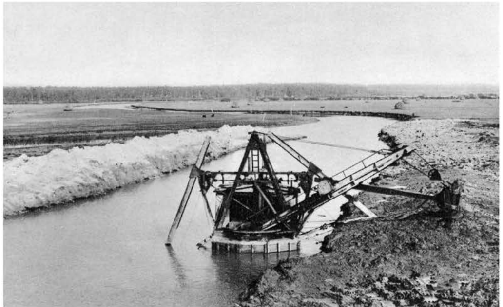
Kärevere silla kanali kaevamine.
