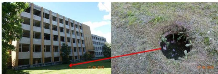
Katmata kaev tiheda liiklusega tänava ääres. Järveküla tee 40, Kohtla-Järve linn.
