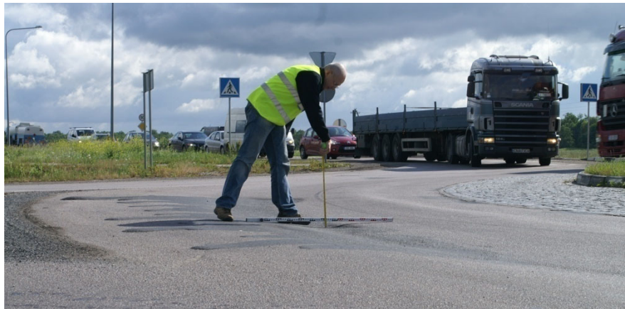
Foto 2. Ühe suurema liikluskõormusega põhimaantee Tallinna ringtee Jüri ringil, kus on hästi näha, kuidas nii bituumen kui ka killustik on suure liikluskõormuse tõttu august välja tulnud ja tee tasasus ei vasta kindlasti seisundinõuetele.
