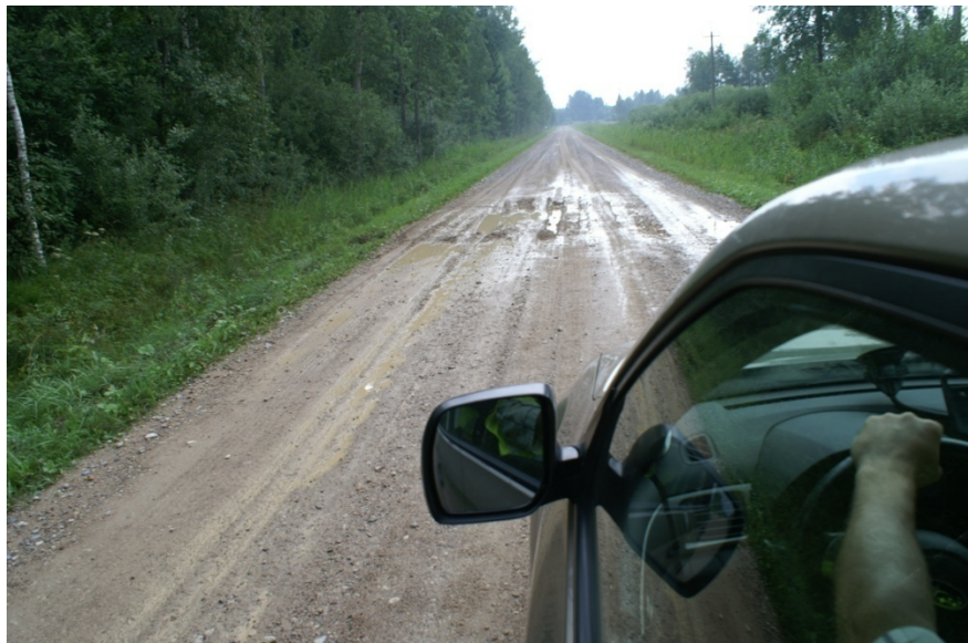
Foto 12. Selline Eesti teedel küllaltki sageli esinev vaatepilt on tegelikult üks raskemaid eksimusi tee seisundinõuete vastu. Vesi ei tohi mingil juhul tee peale püsima jääda, eriti suure liiklusköormusega kruusateel muudab see tee sõiduautodele kiiresti läbimatuks.
