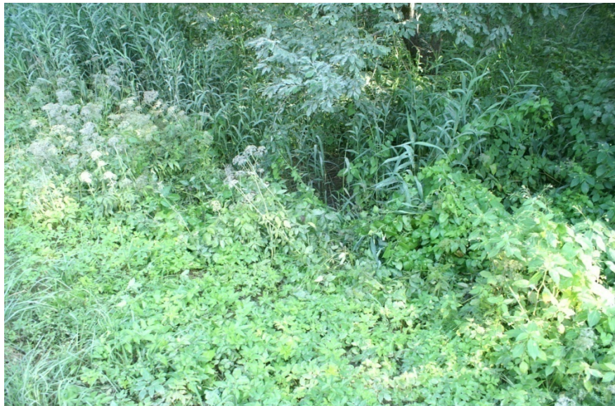
Foto 11. Truubid ja kraavid peavad olema võsast, umbrohist ja prahist puhtad, vastasel juhul on vee äraliikumine vaevamine ja see on tee muldkehale suureks ohuks. Nii paksult kinni kasvanud truup nagu siinsel fotol viitab otseselt nii hooldaja kui ka järelevalvaja tegematajätmisele.
