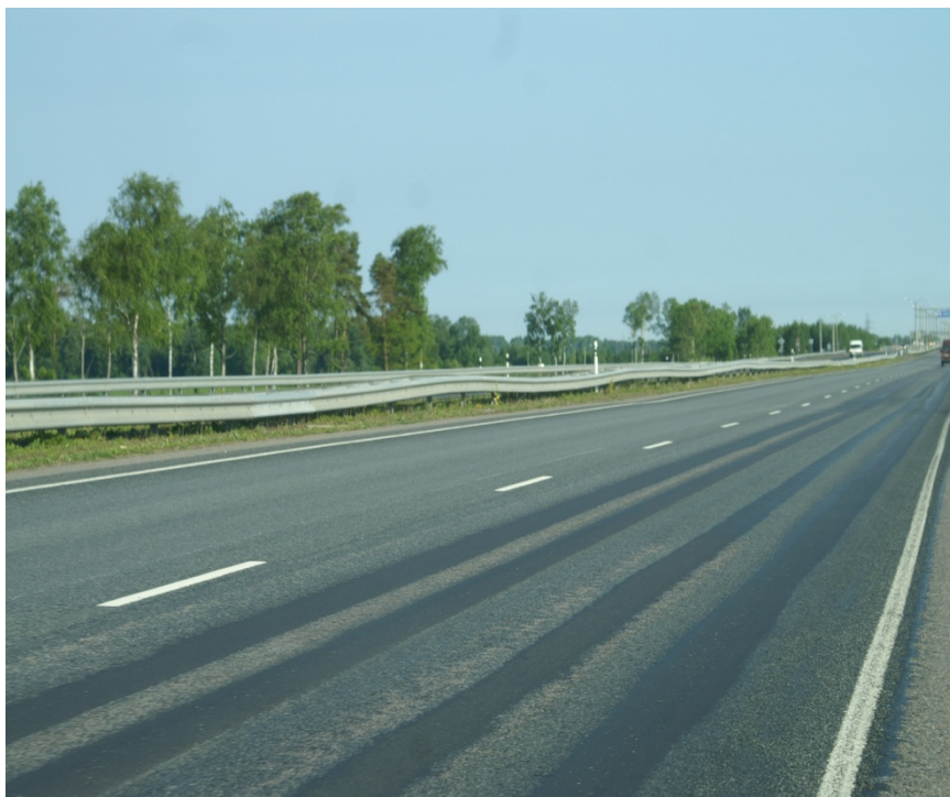
Foto 5. Talihooldega rikunud pörkepiire Tallinna-Tartu maanteel, mis ei kaitse vastutulijate tulede valguse eest ega välista ka sõiduki vastassuunda sõitmist. Pilt on tehtud 31. mail 2011.
