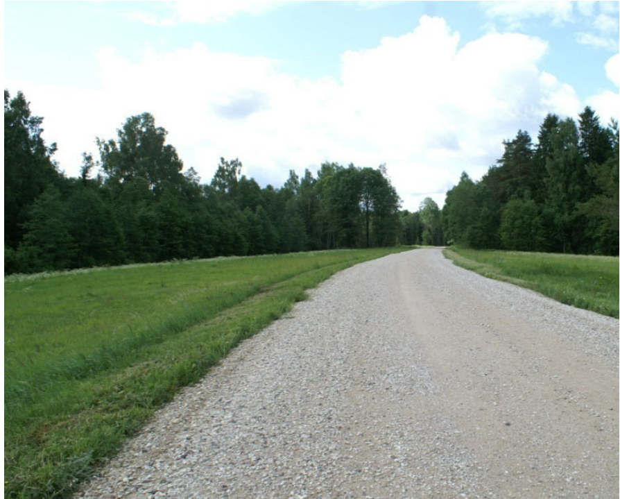
Foto 4. See äsja remonditud kruusatee on küll sile ja ilma aukudeta (vastab selles osas seisundinõuetele), kuid kaetud lahtiste kividega, mis sõiduautoga kiiremini kui 40 km/h ohutult liigelda ei võimalda. Seega on tee sisuliselt libedam kui talvisel ajal.
