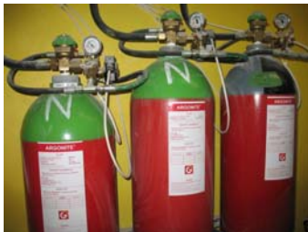
Eesti Kirjandusmuuseumi arhiivraamatukogus renoveeriti 2006. aastal uute hoidlate gaaskustutussüsteem.
